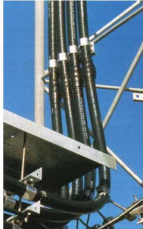
Fig. 9.26. Curvatura en líneas semiflexibles.
