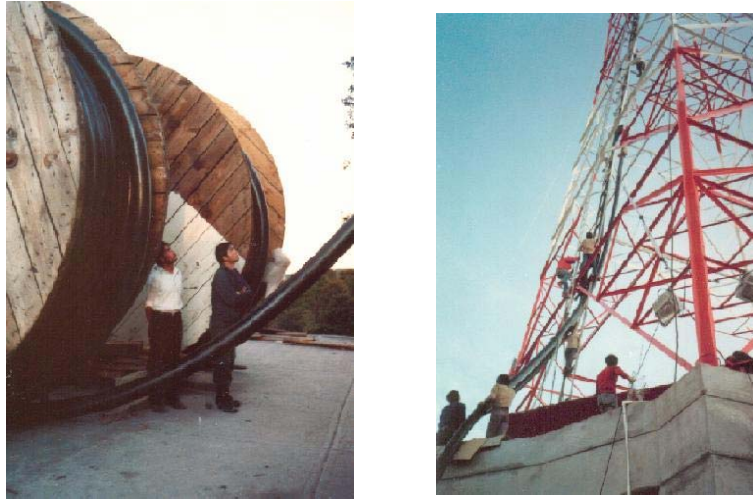
Fig. 9.24. Montaje de una línea de transmisión de 6.5".
